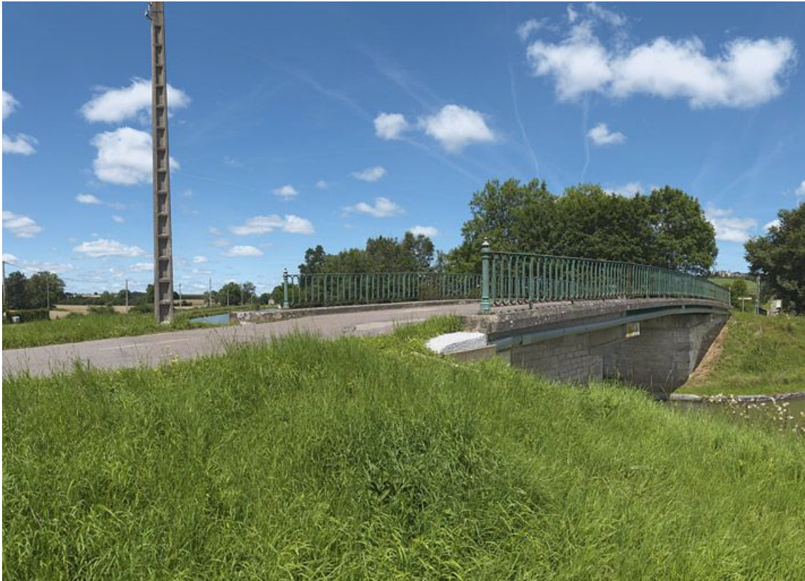
Le pont routier vu d'aval.
