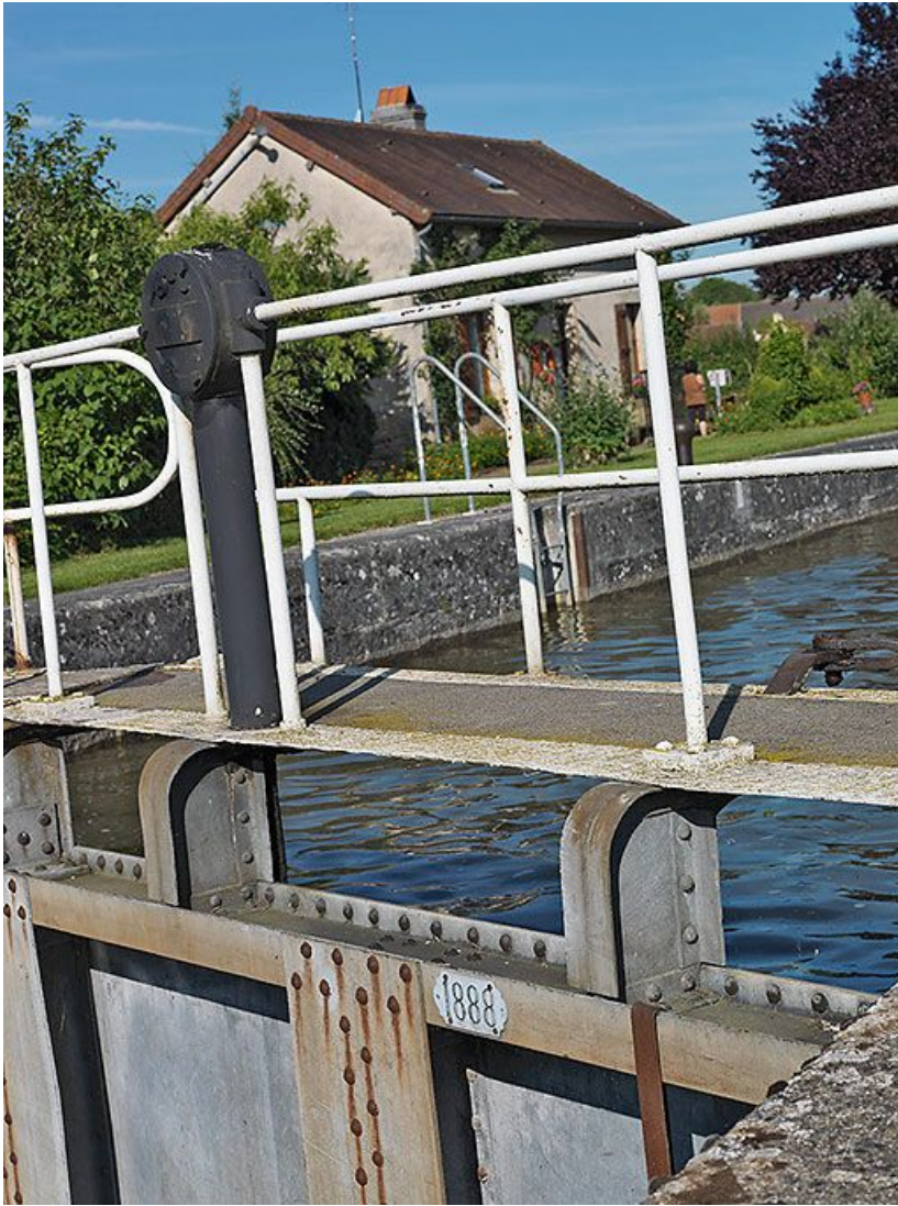
Détail des portes aval avec date portée 1888.
