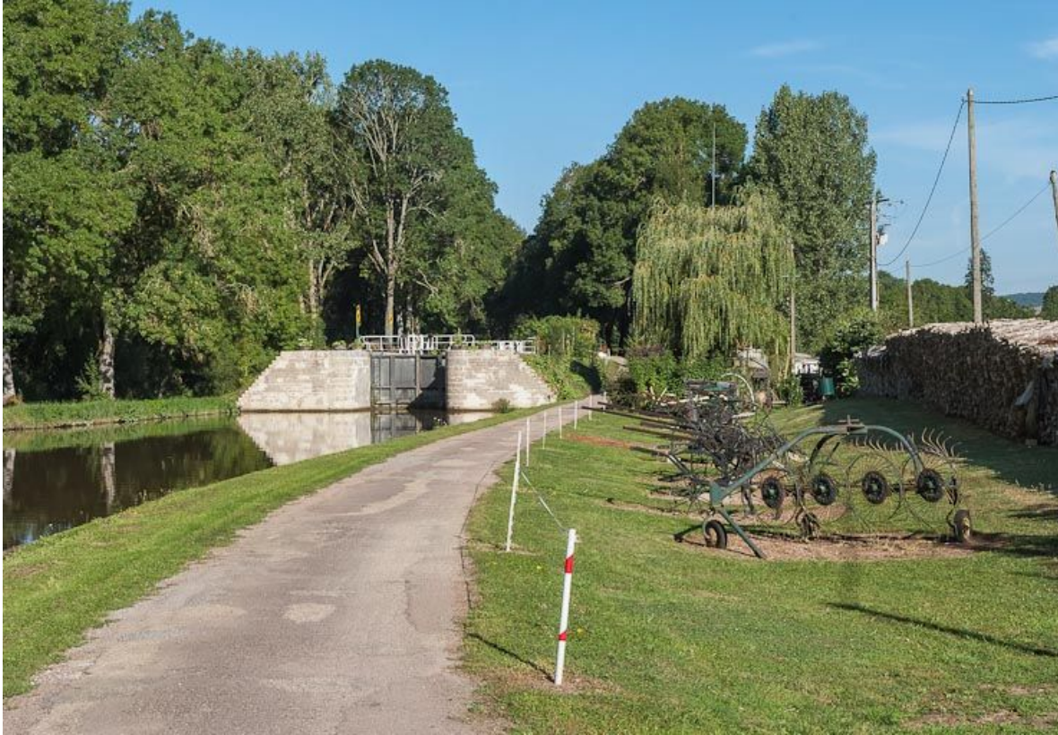
Vue rapprochée de l'écluse depuis l'aval.
