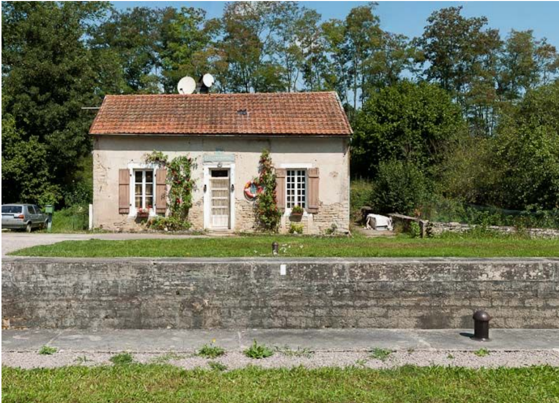
Vue de face de la maison éclusière.
