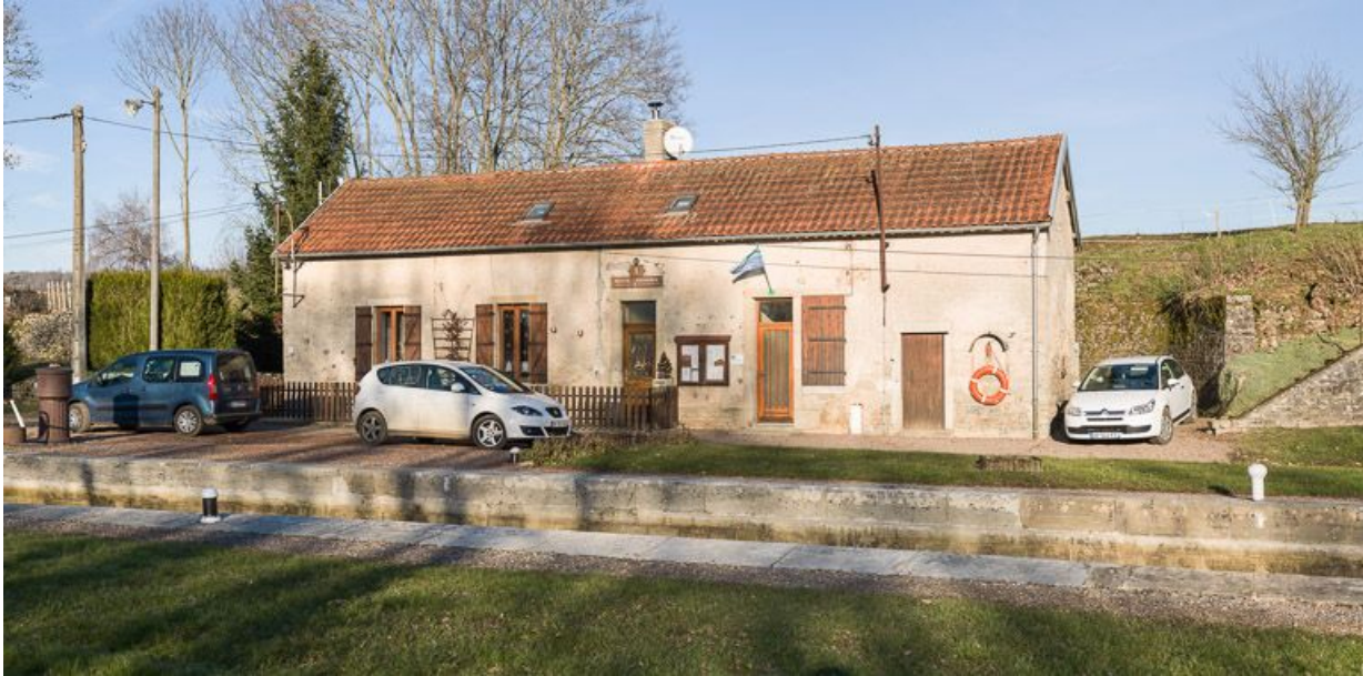
La maison éclusière vue de 3/4.
