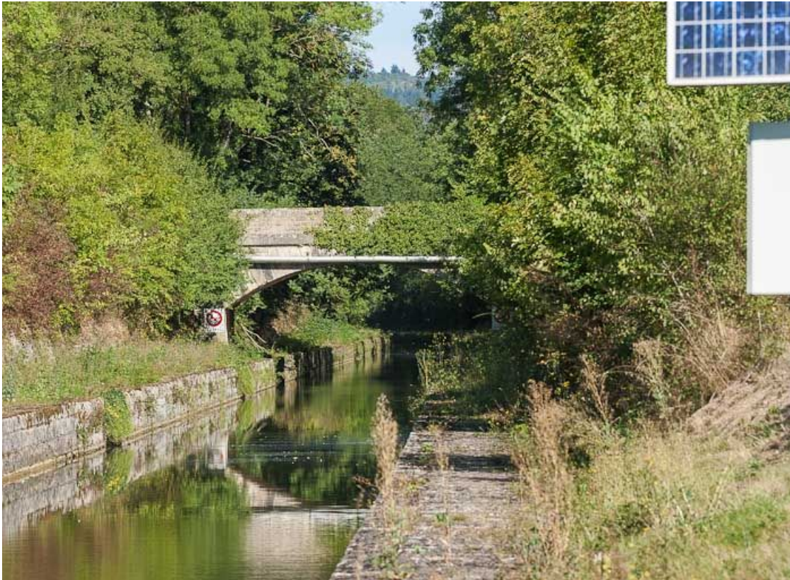
Vue du pont depuis l'aval.
