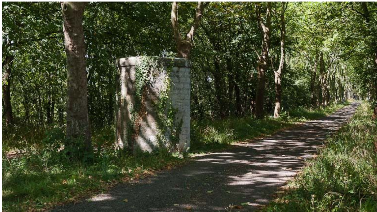
Vue d'un puits d'aération du tunnel.
