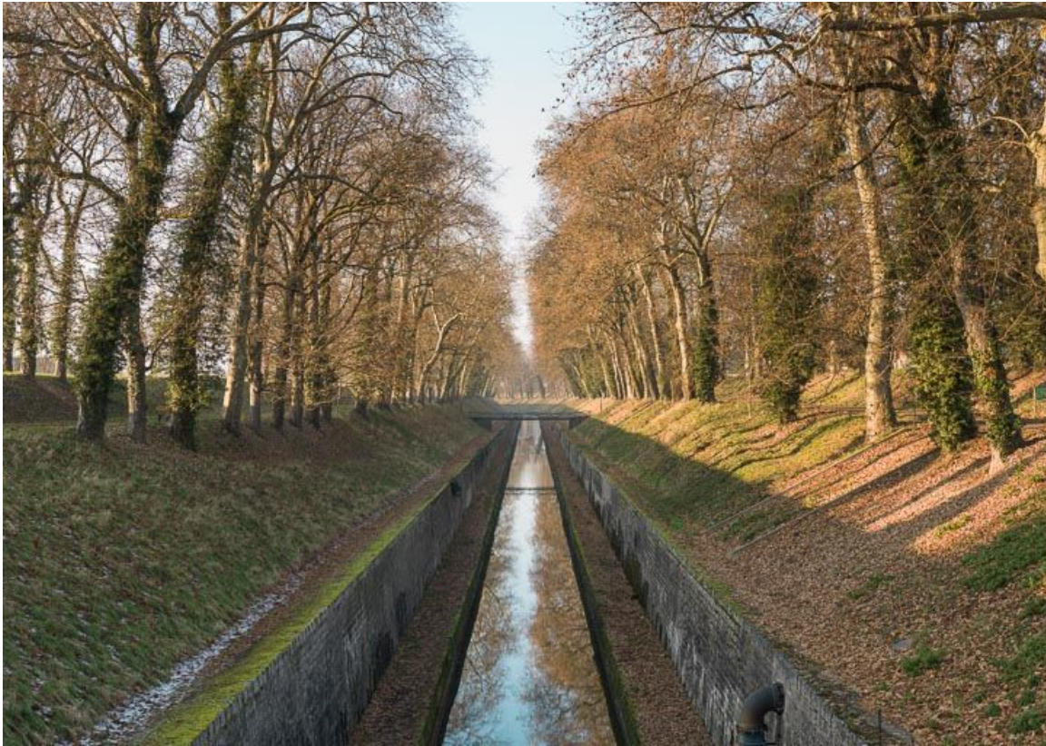
Vue d'ensemble de la tranchée.
