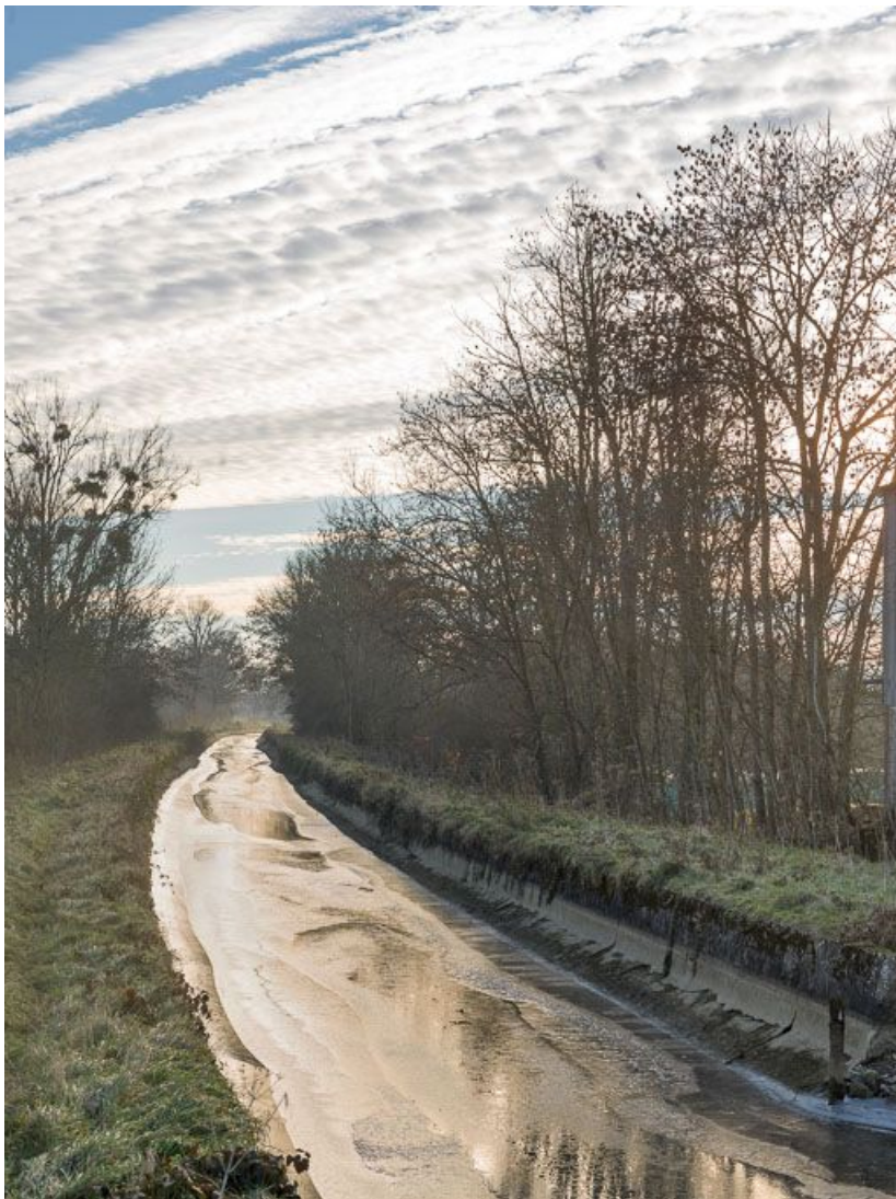
La rigole d'alimentation rive gauche.
