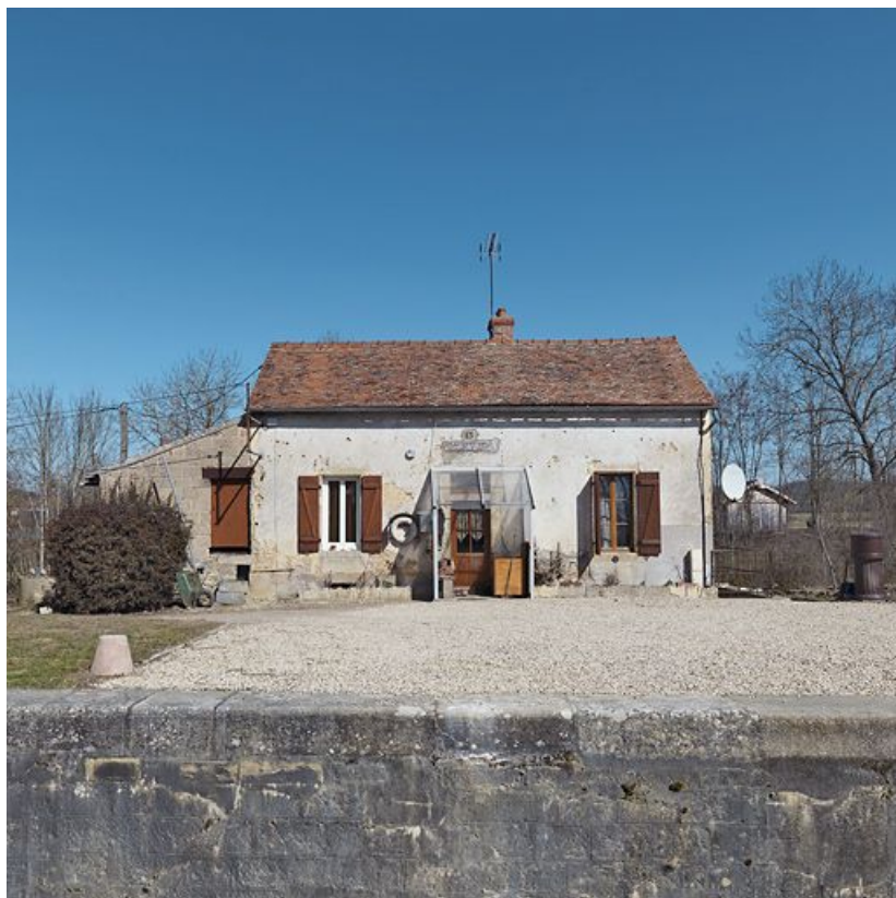
La maison éclusière de face.
