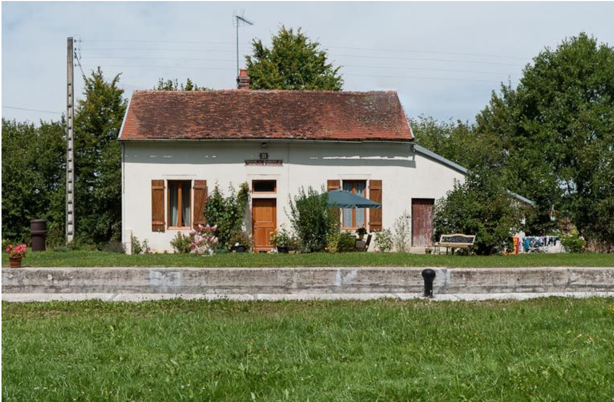
Vue de face de la maison éclusière.
