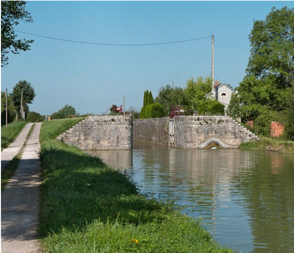
Vue du site d'écluse depuis l'aval.
