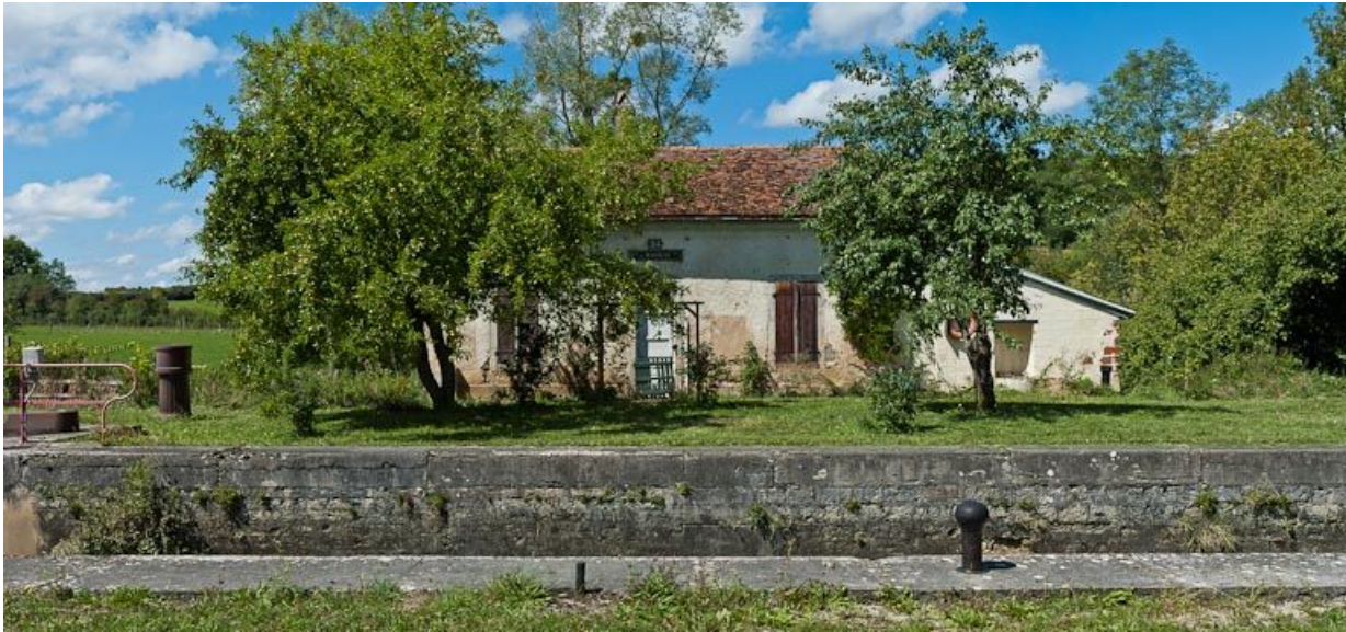
Vue de face de la maison éclusière.
