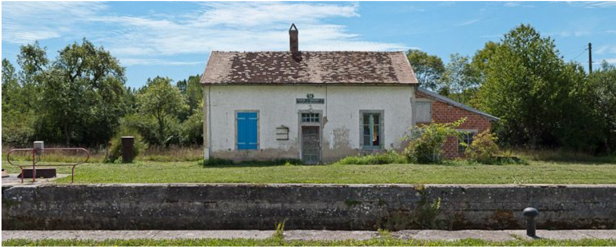
Vue de face de la maison éclusière.
