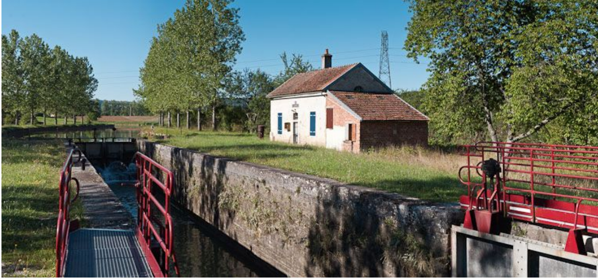
Vue d'ensemble du site d'écluse.
