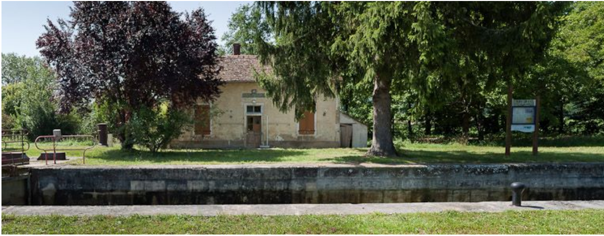
Vue de face de la maison éclusière.
