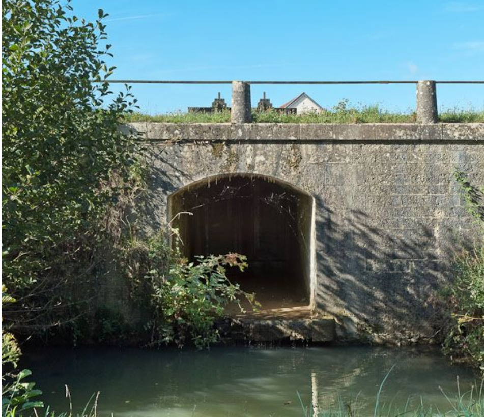
Vue de l'aqueduc.
