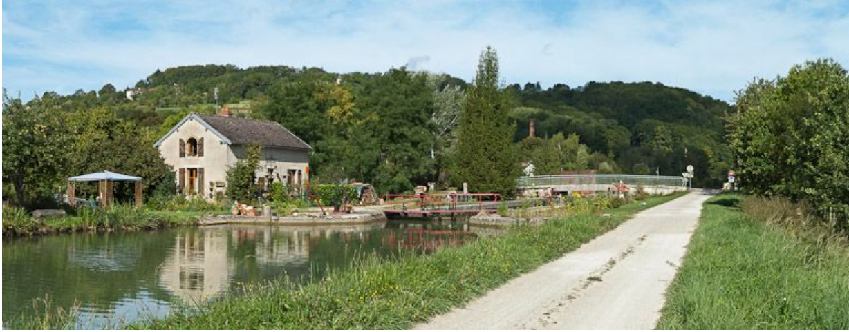
Vue du site d'écluse depuis l'amont.
