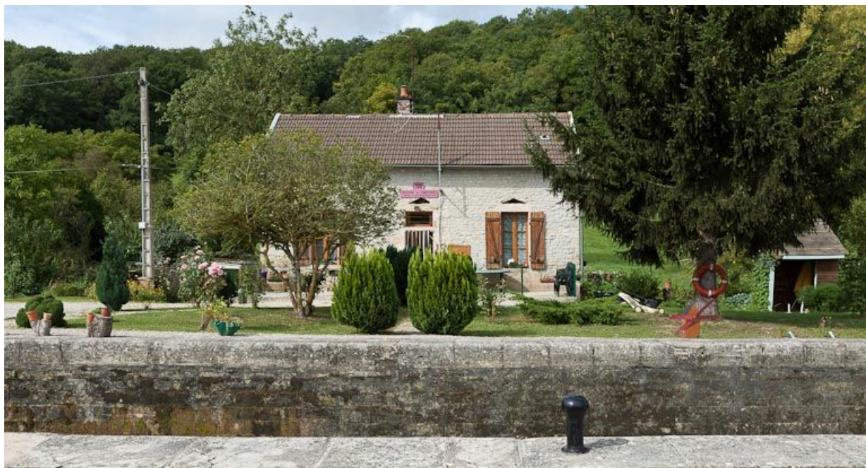
Vue de face de la maison éclusière.
