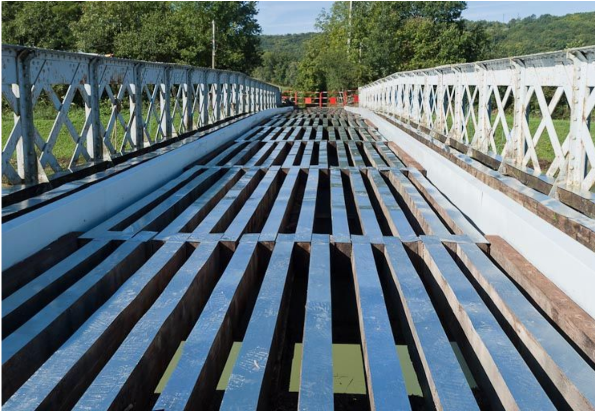
Vue du tablier pendant les travaux.
