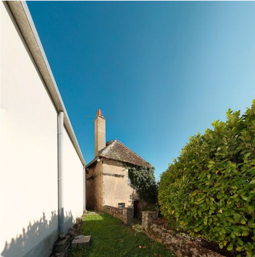
Construction ancienne incluant la tour de Poilbourg.
