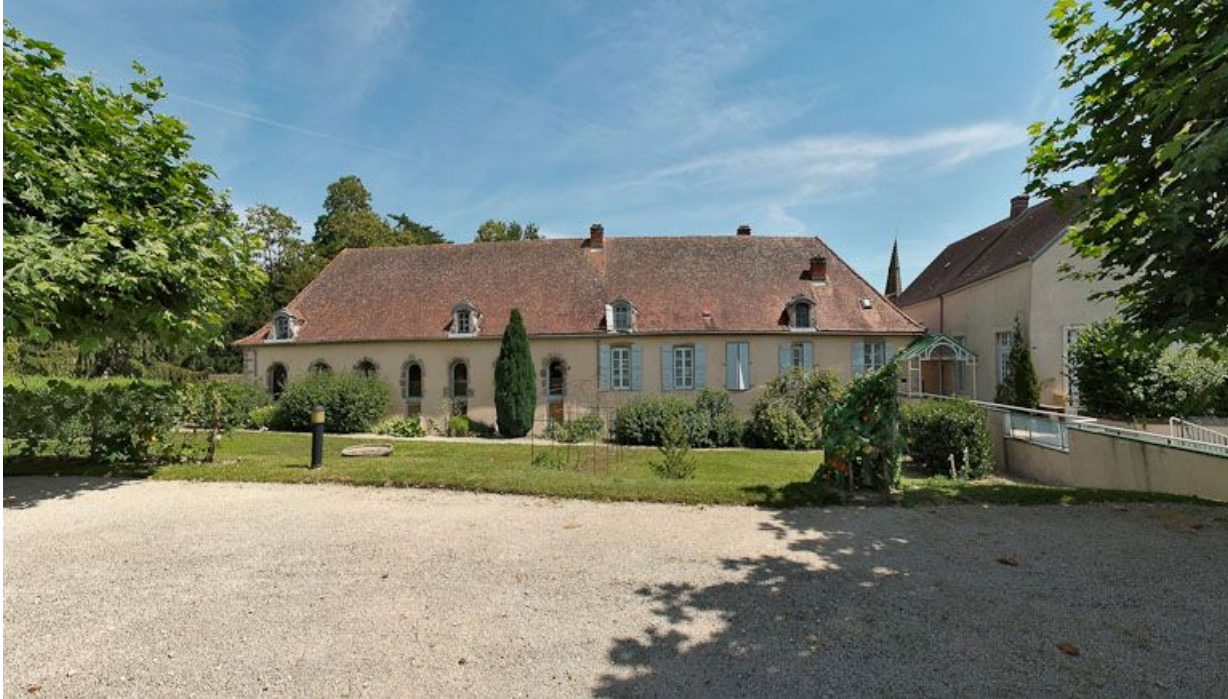
Façade postérieure de l'ancien hôpital.
