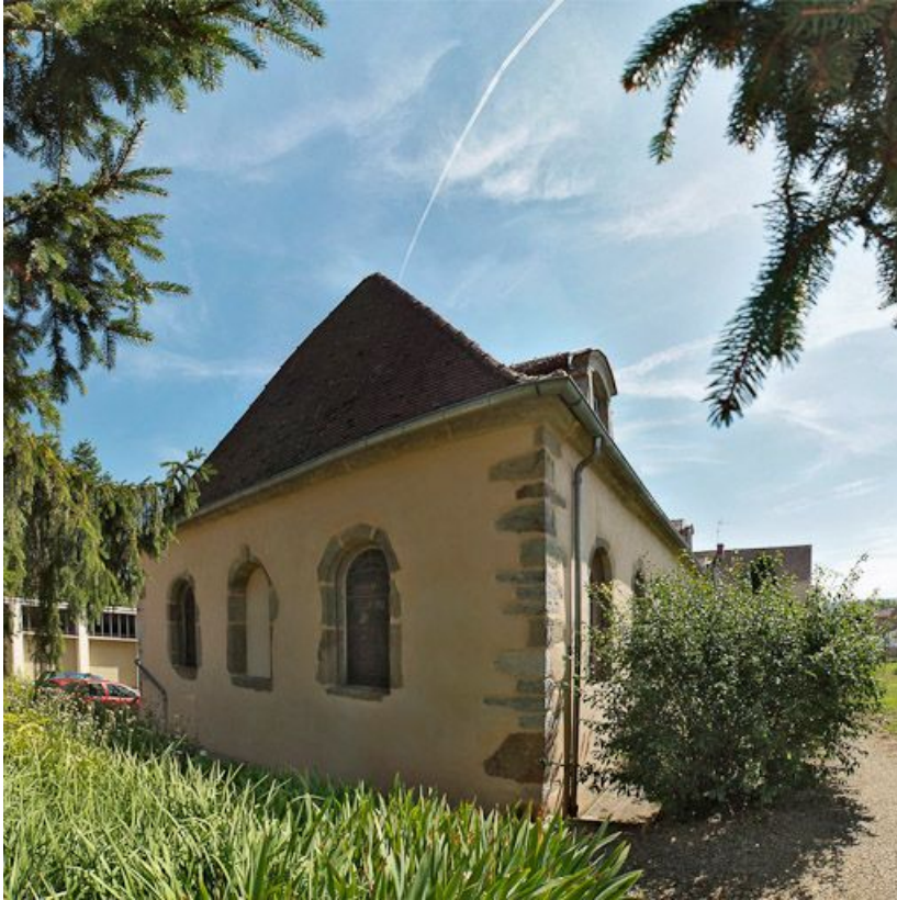
Elévation droite (ancienne chapelle).
