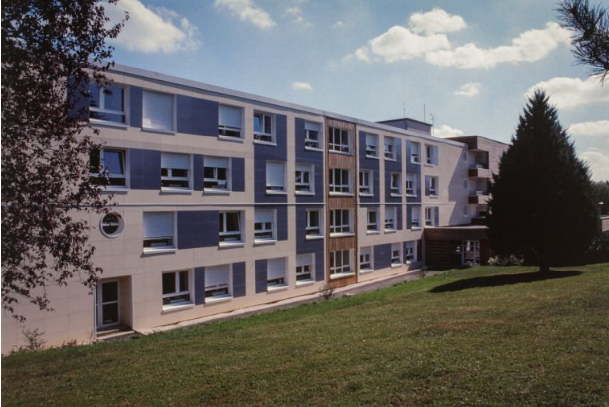
Maison de retraite, élévation latérale.
