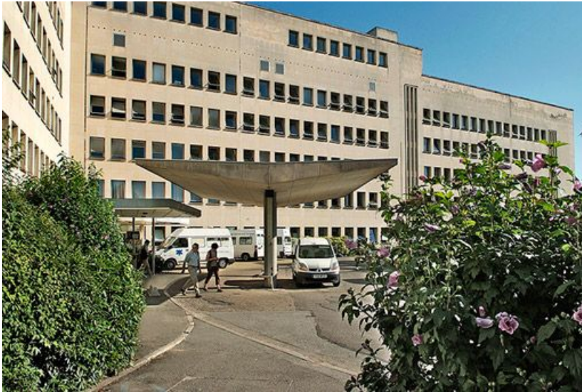
Entrée du bâtiment et aile droite.
