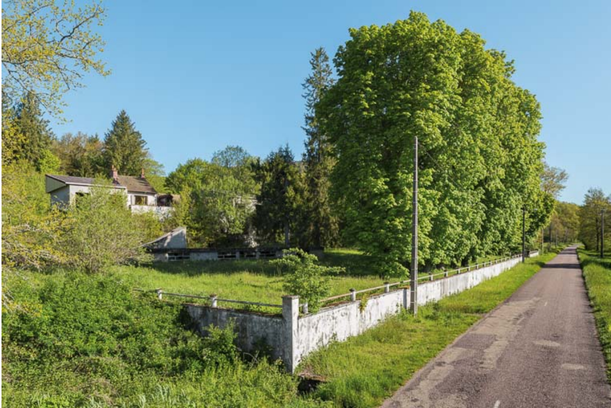
Vue de trois-quarts depuis le sud-ouest.
