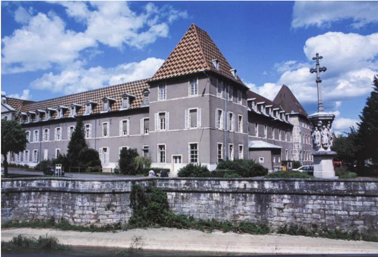
Vue prise du sud-ouest.
