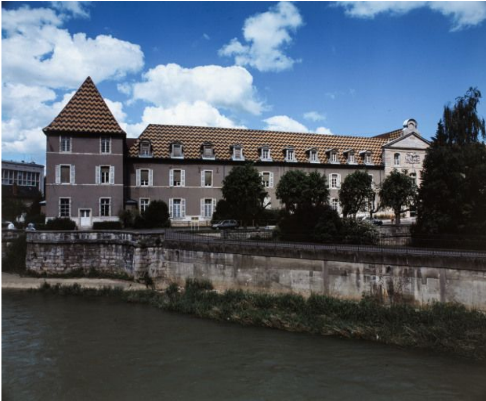
Façade postérieure (ouest) sur l'Ouche. 21, Dijon Hôpital
