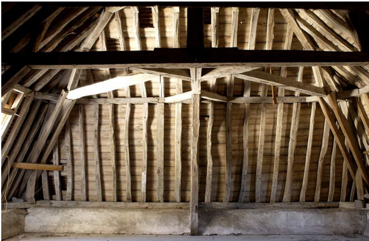
Aile droite : charpente, croupe sur la salle Sainte-Marthe.
