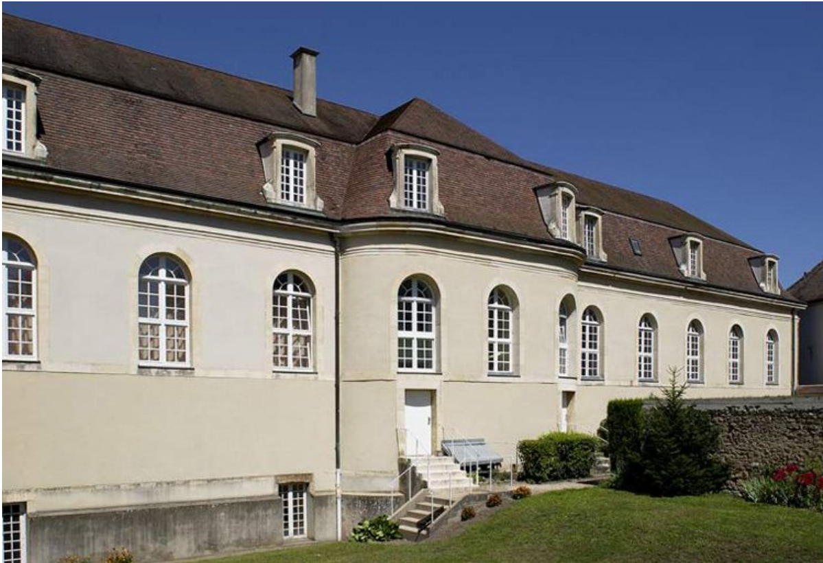
Aile gauche dite fondation Arnault : élévation postérieure.
