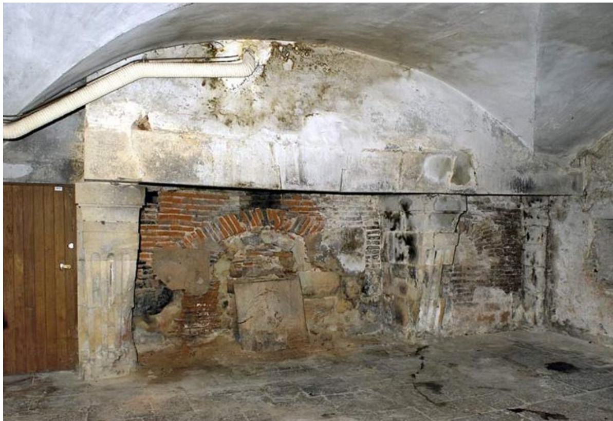
Ancien hôtel du gouverneur : sous-sol, cheminée.
