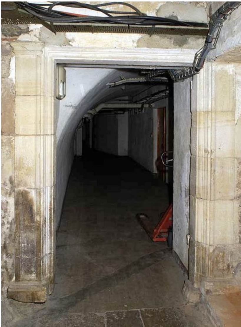
Ancien hôtel du gouverneur : sous-sol, porte.
