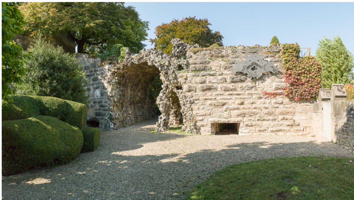
Passage aménagé dans l'ancienne courtine.
