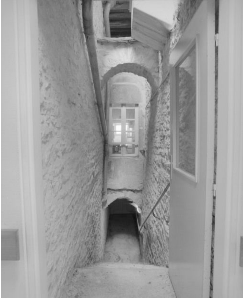
Vue de la venelle, prise de l'étage.
