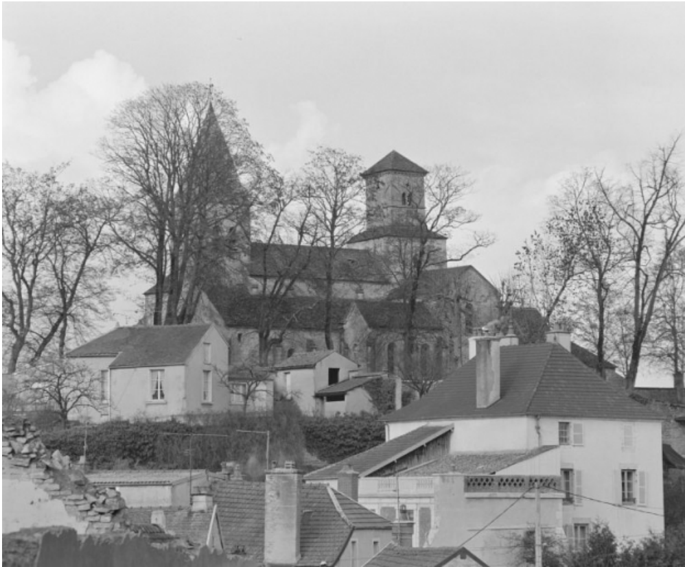
Vue d'ensemble du site, au sud
