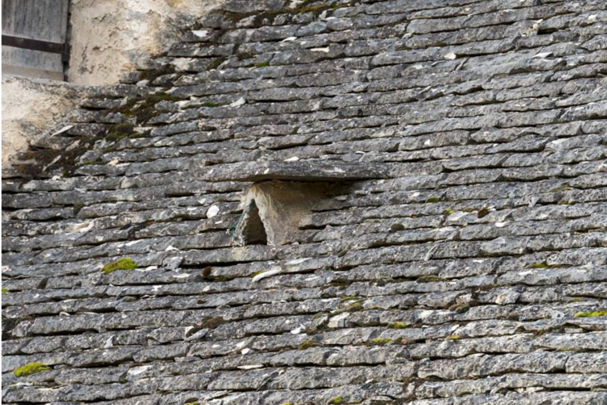
Détail de la toiture côté nord.
