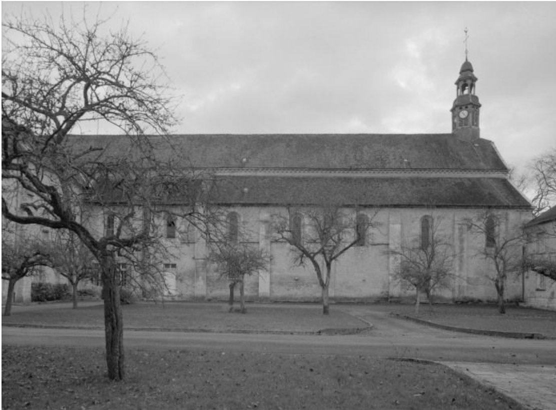
Eglise : élévation gauche.
