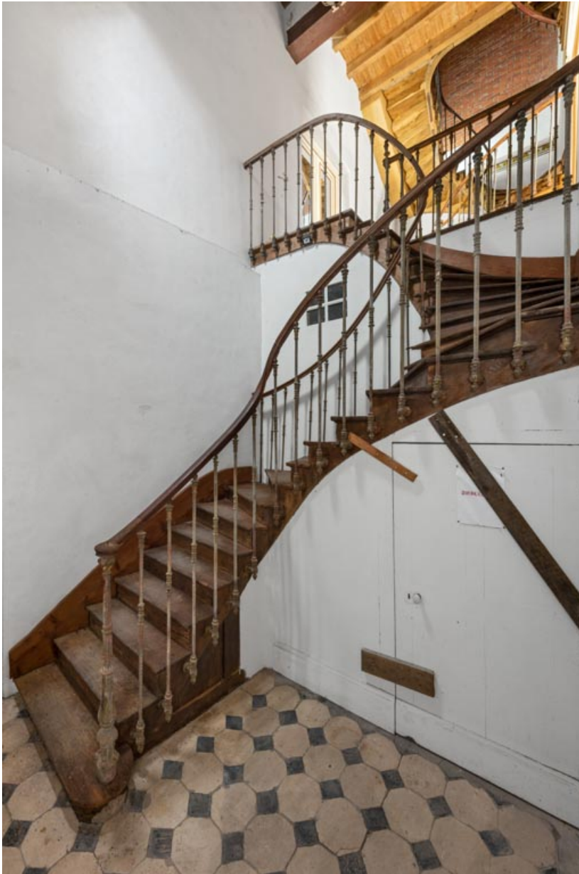
Corps sud : escalier desservant le 1er étage.
