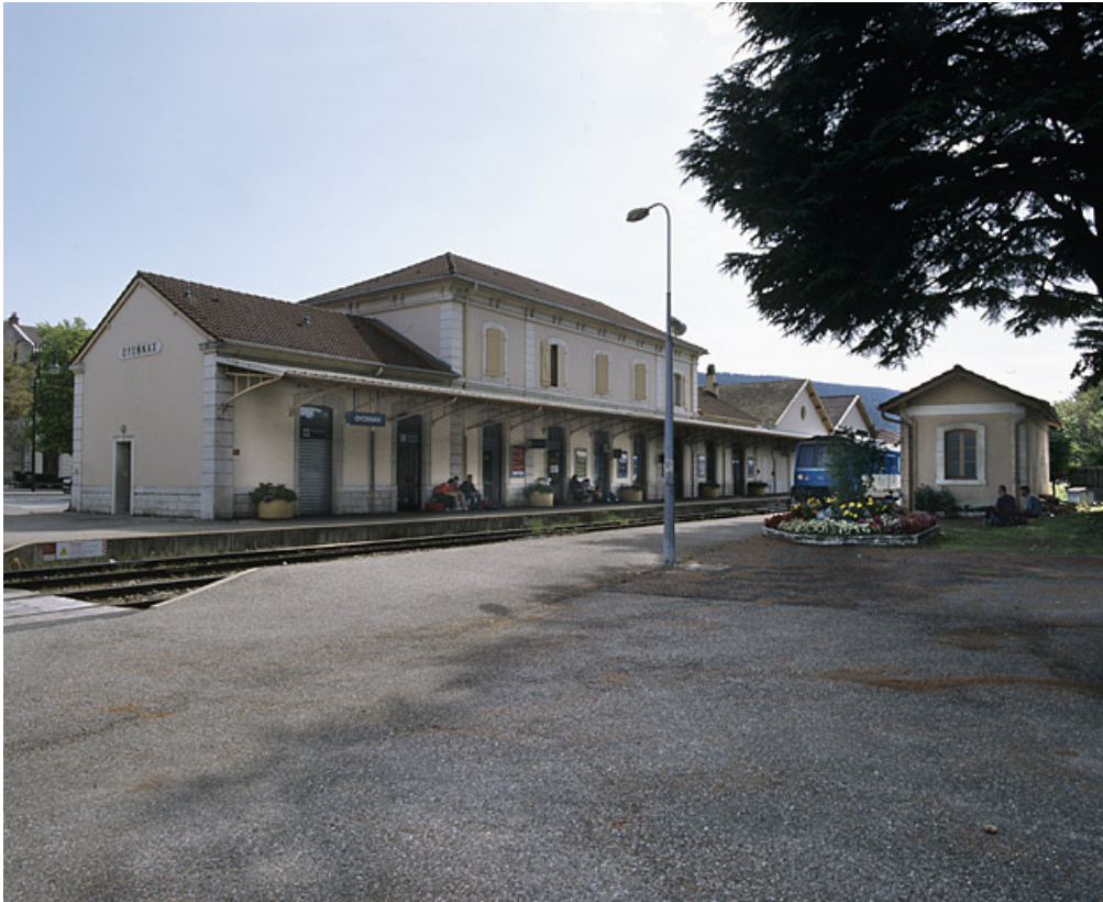
Vue d'ensemble, depuis le nord-ouest (côté Andelot-en-Montagne).
