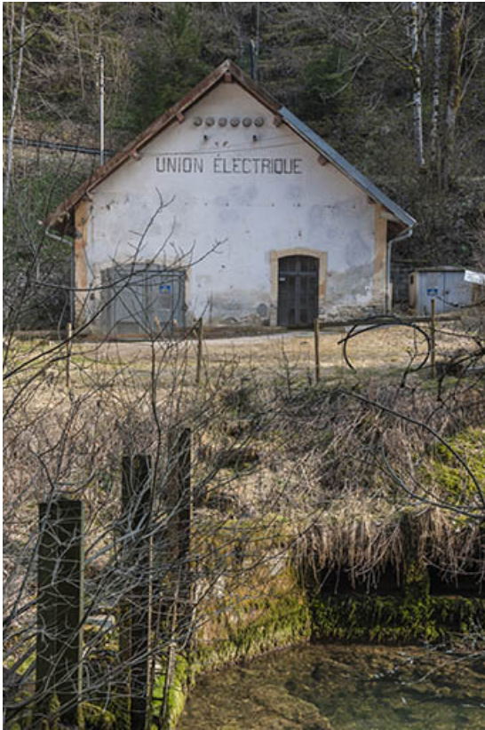
Façade antérieure de la centrale.
