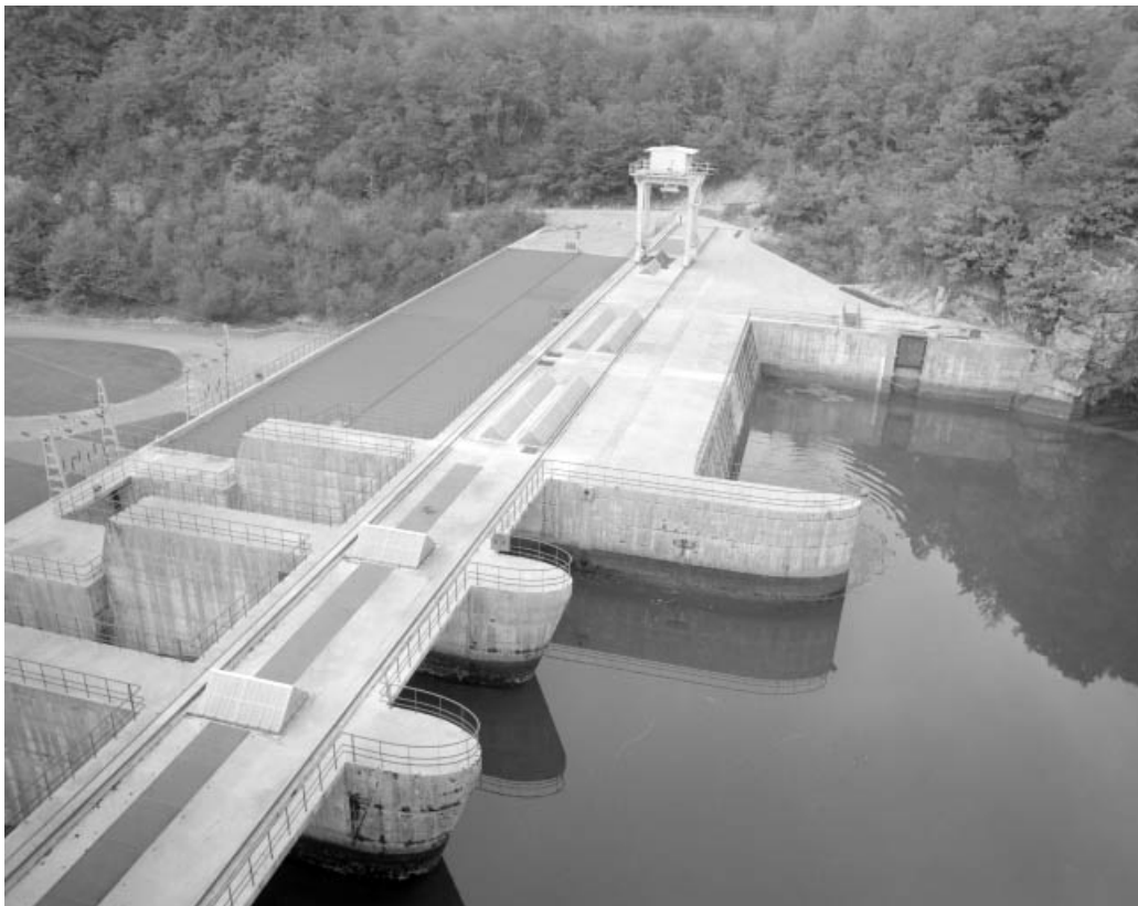
Evacuateur de crue et toiture de l'usine.
