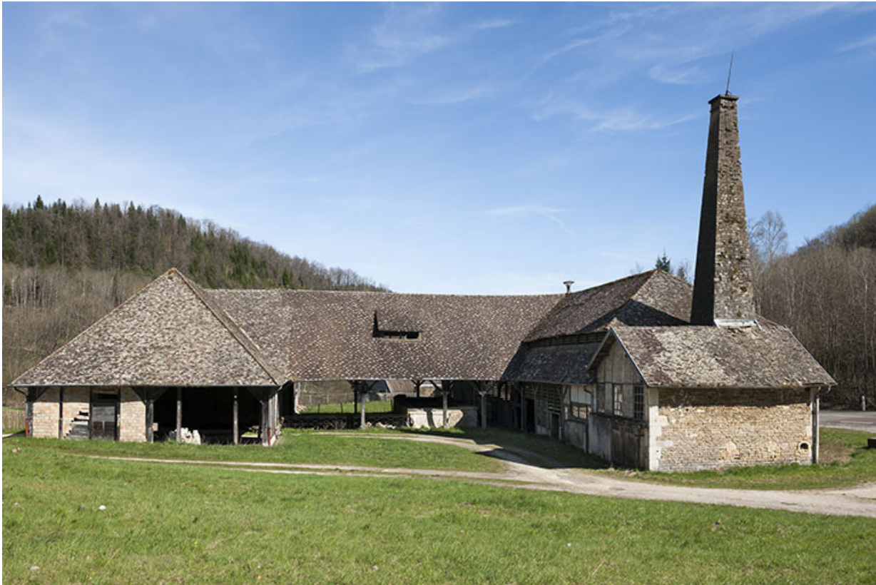
Vue rapprochée depuis l'ouest.
