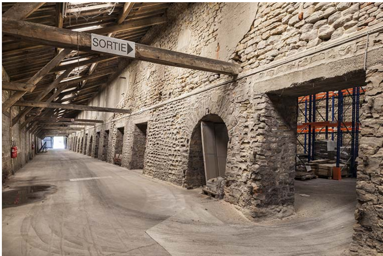
Ancien quai de chargement.
