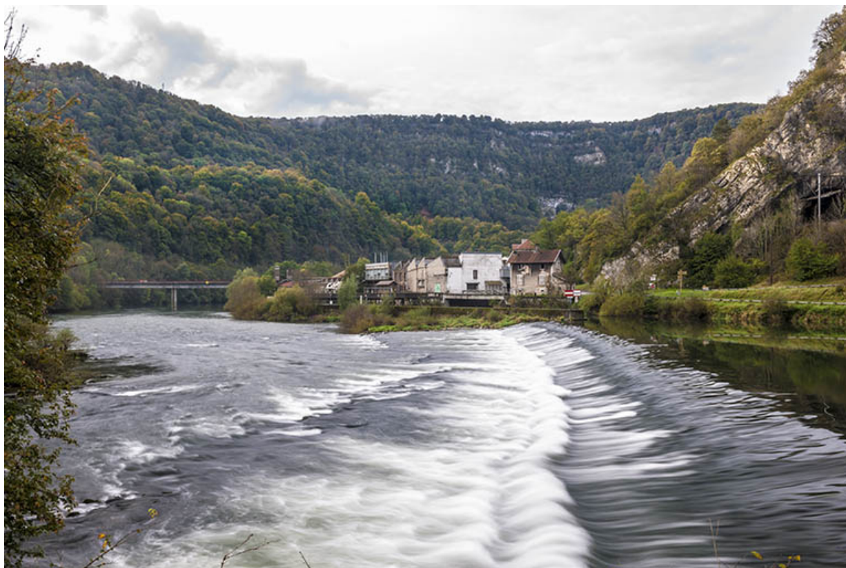
Vue d'ensemble depuis l'extrémité orientale du barrage.
