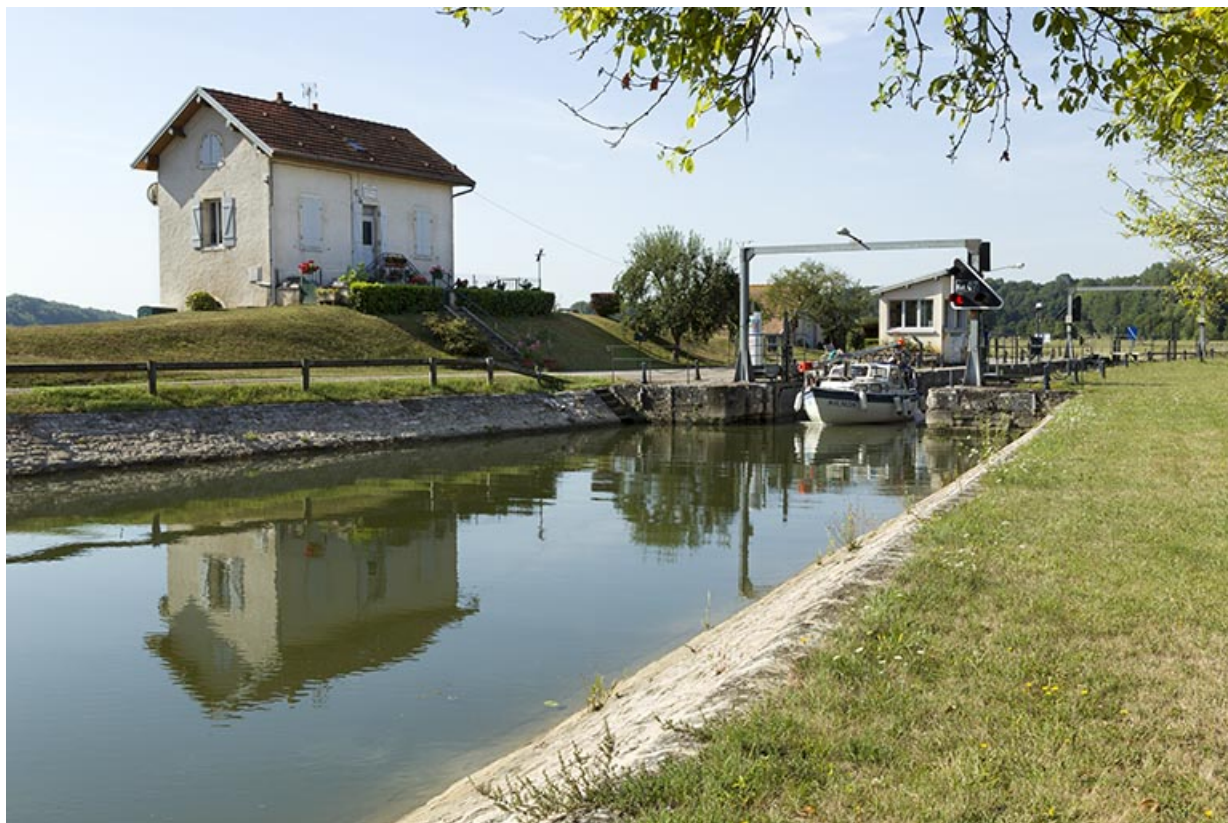
Vue amont du site d'écluse.
