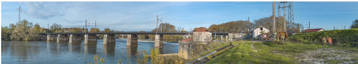
Le pont ferroviaire d'Auxonne (21).
