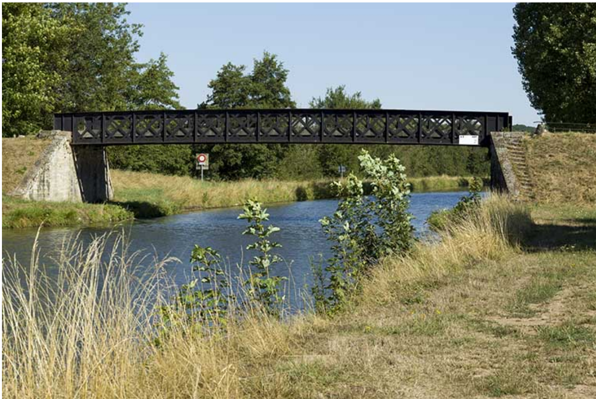
Le pont depuis l'aval.
