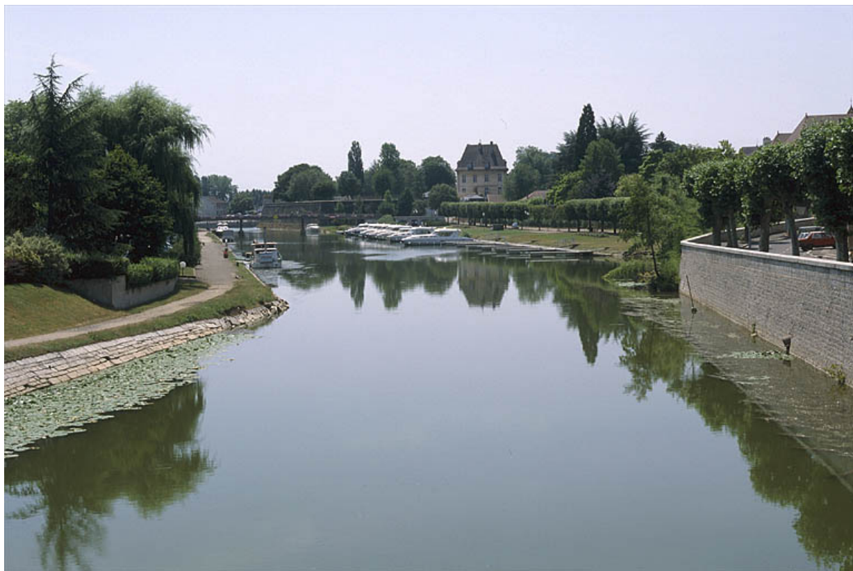
Canal entre écluses 66 et 67.
