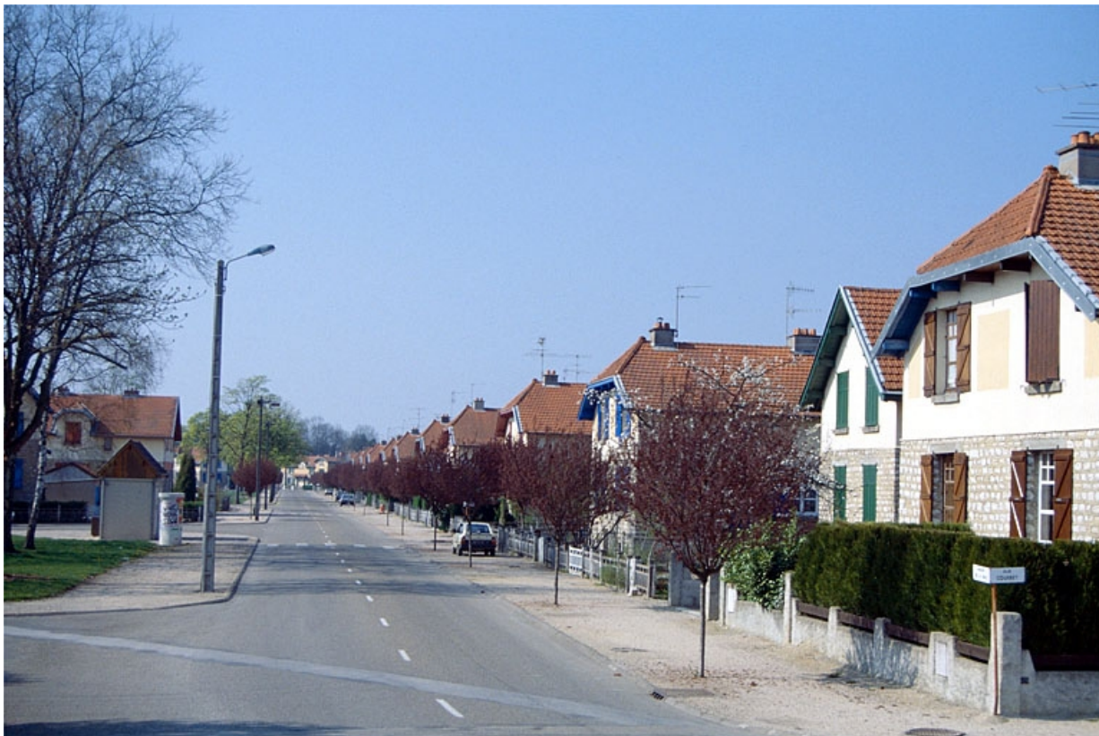
Vue générale de l'avenue de la Paix.
