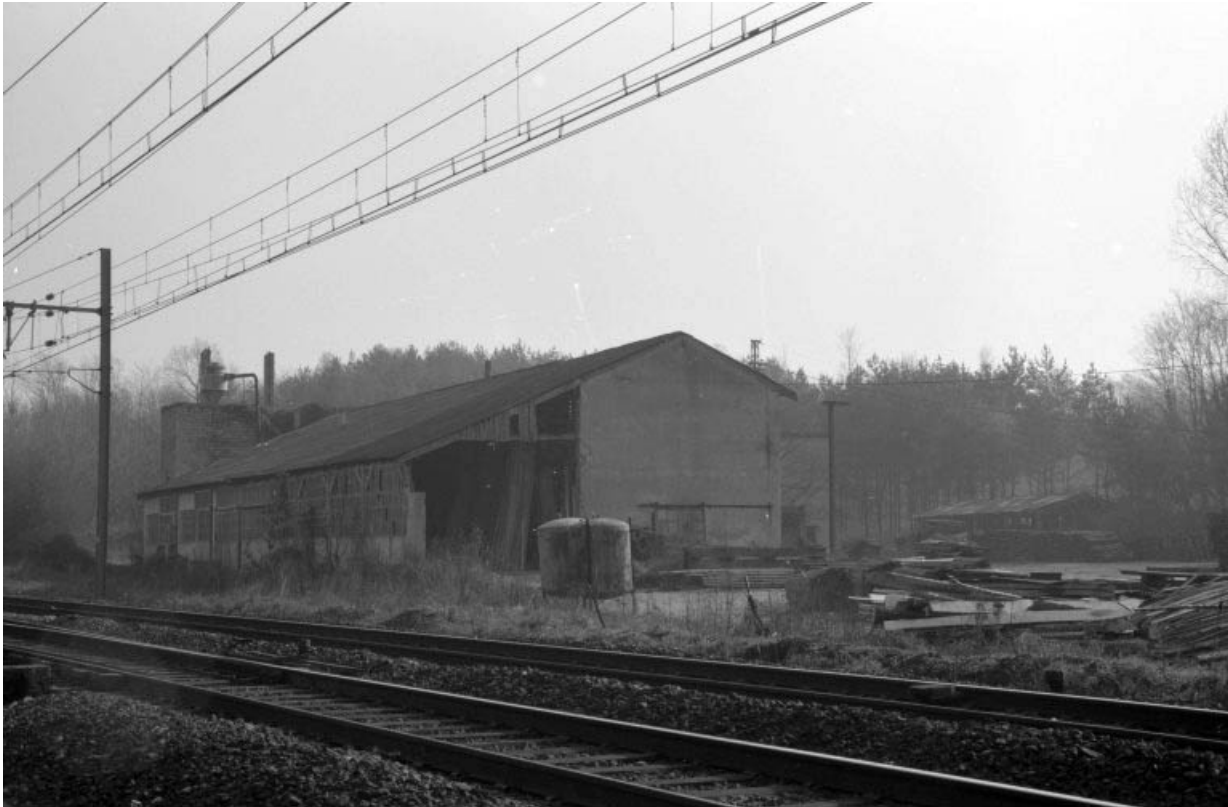
Menuiserie (M), depuis le nord-est.
