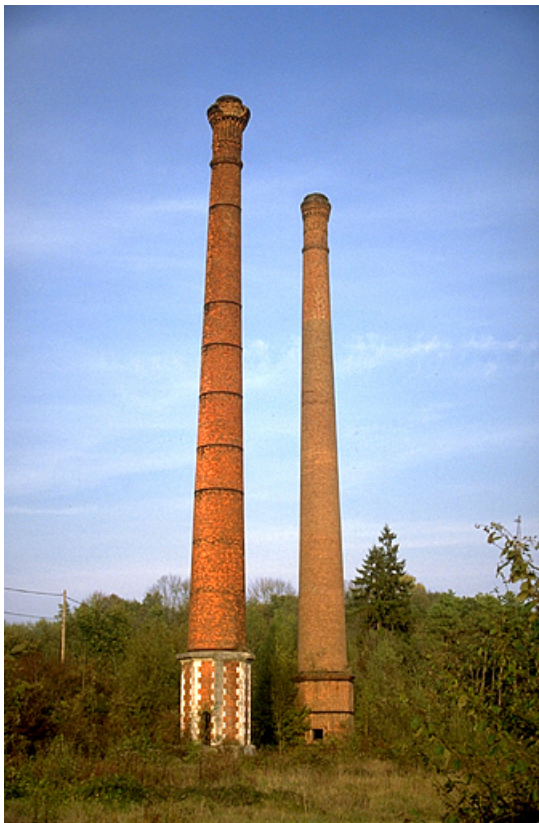
Cheminées d'usine, depuis le sud-ouest.
