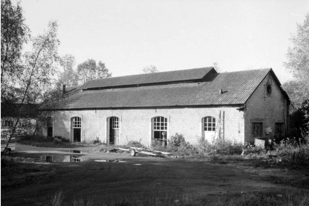
Atelier de réparation, de trois quarts droit.
