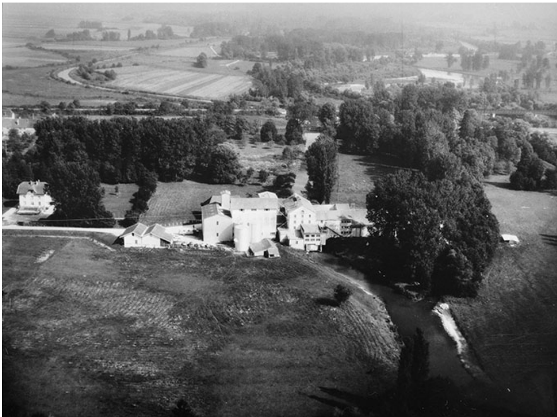
Vue d'ensemble depuis l'ouest (vue aérienne).
