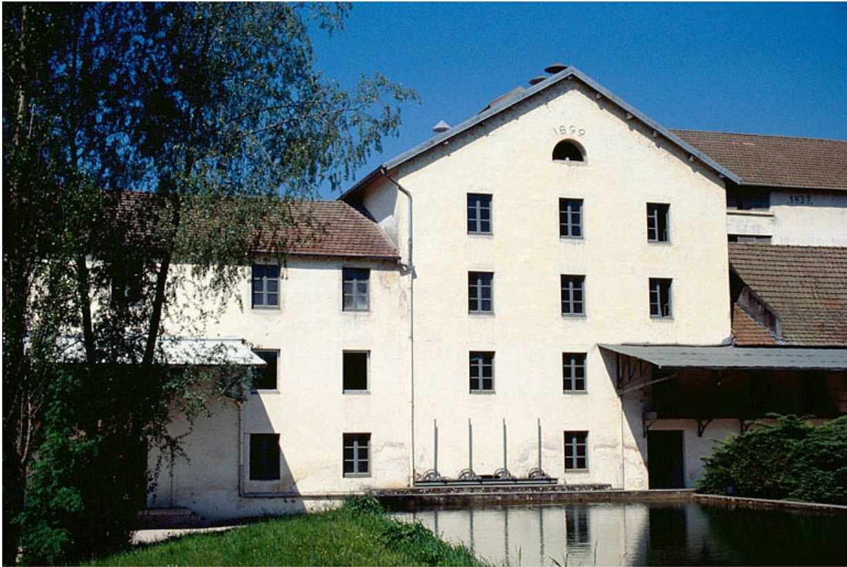
Façade antérieure de l'atelier de fabrication (L).
