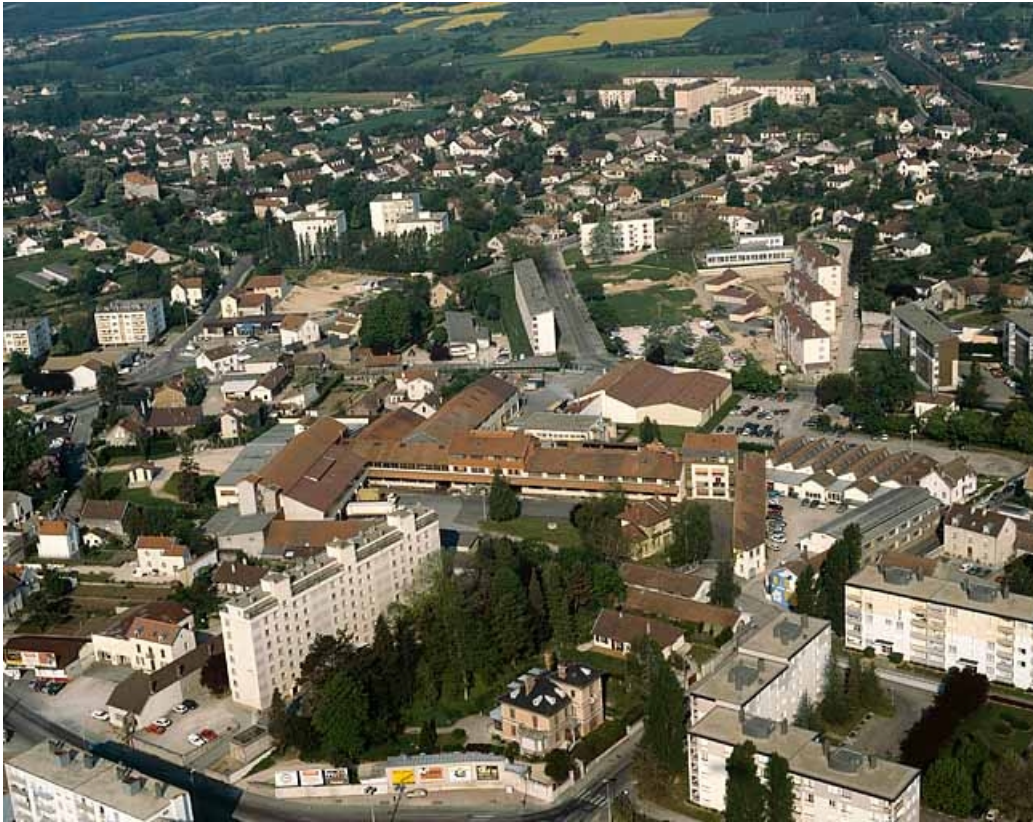
Vue aérienne depuis l'est (vue rapprochée).
