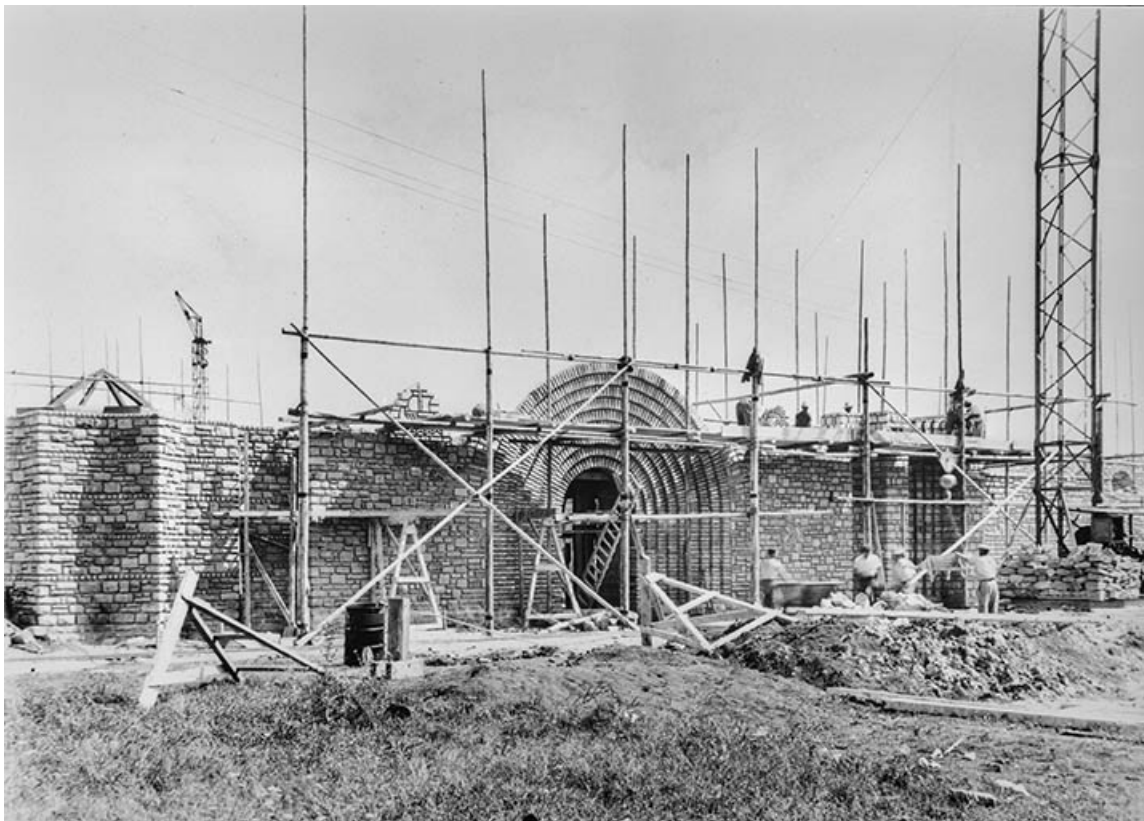
Travaux de construction de l'église, façade ouest.
