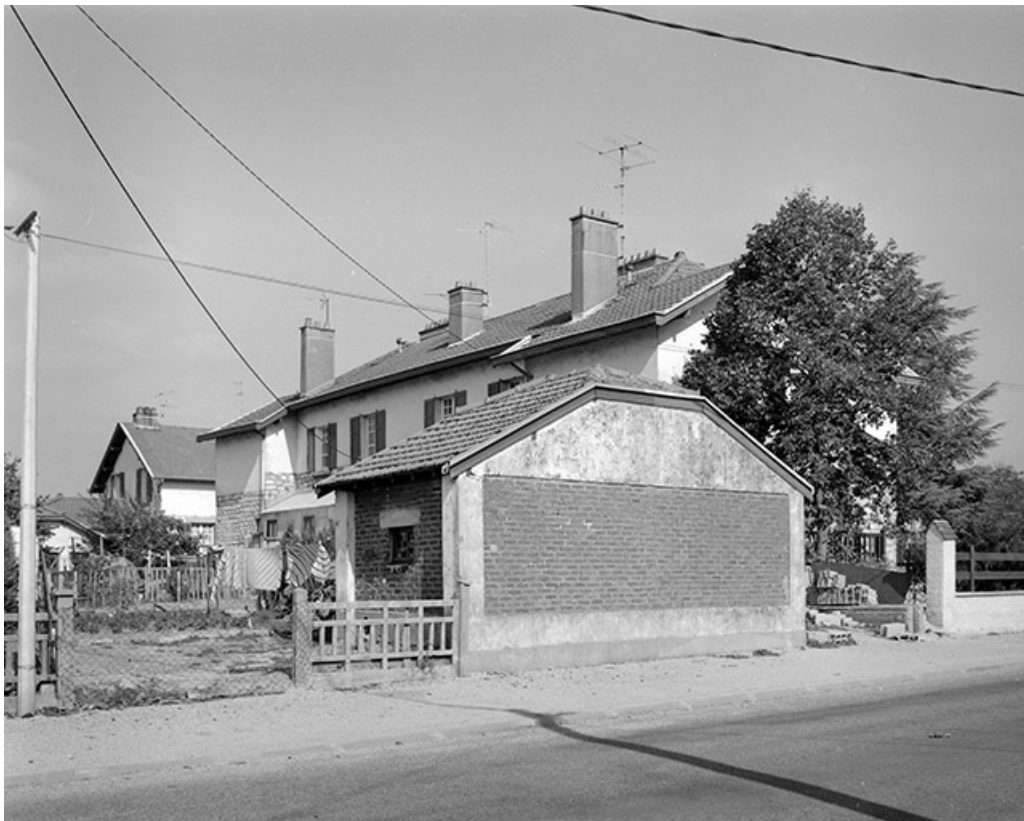
Façade postérieure et face latérale gauche.
