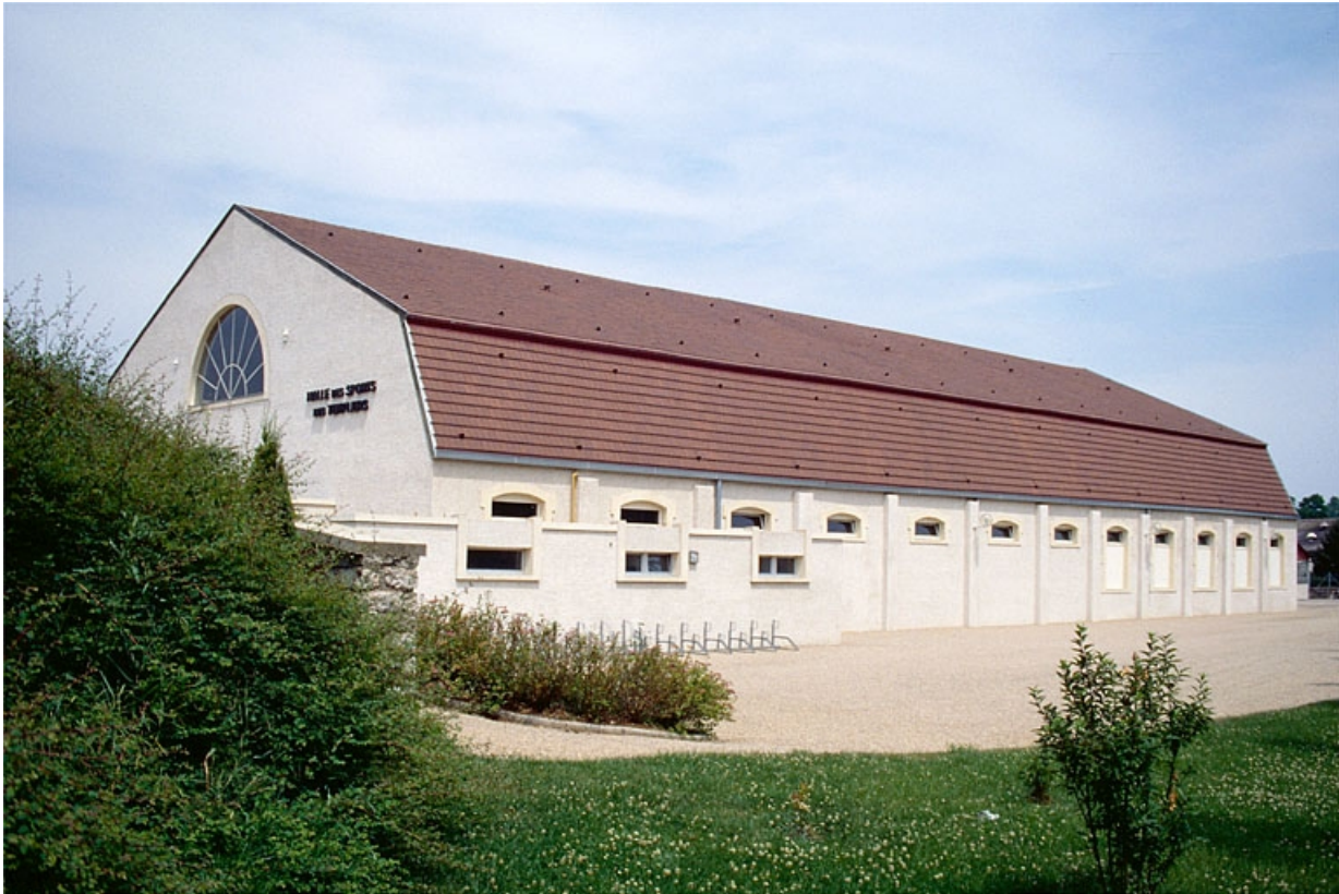
Façade latérale gauche du gymnase.
