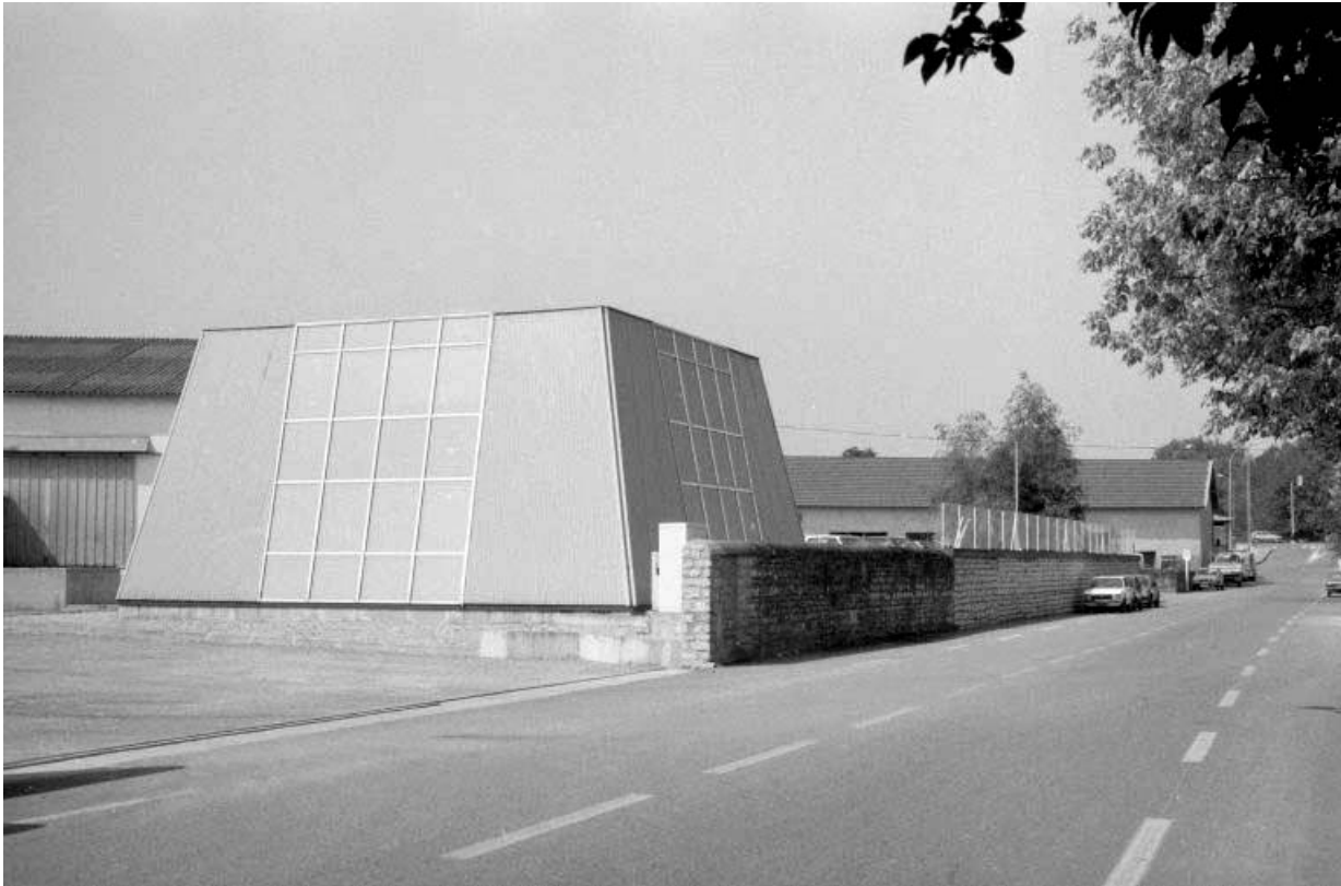
Bâtiment de la société SERIG.
