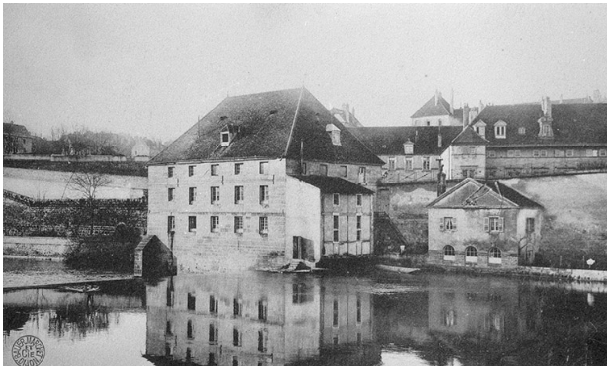
Dole - Ancien Moulin - Machine élévatoire.
