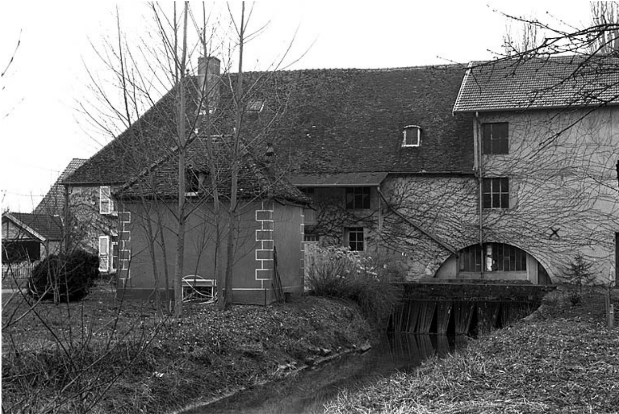
Bureau et minoterie, depuis le nord-est.
